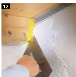
12 Završni premaz Kada se armatura potpuno osuši, nanijeti završni premaz. Odvojiti završni premaz od građevinskog elementa rezom zidarskom žlicom.
