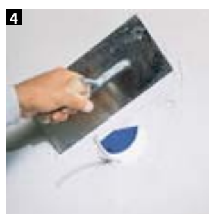
5 Ugraditi Sto-Glasfasergeweb (tkaninu od staklenih vlakana u armaturnu masu).
