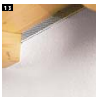
13 Optimalni krovni spoj Gotovo profiliranje ventilacije krova.
