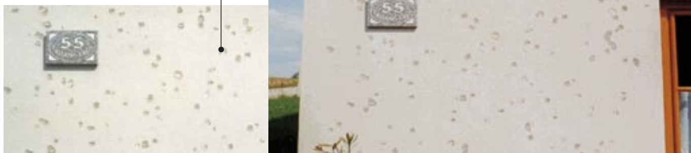
Oštećenja od tuče u okrugu Gmunden, Austrija (04.07.2000.)
